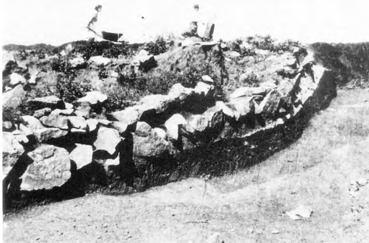
Abb. 20. Žuráň - das Mausoleum wurde direkt über dem Lehm- und Kieshaufen erbaut, der beim Ausschachten der Kammer des I. Grabes entstanden war (Situation südlich des Grabes).
