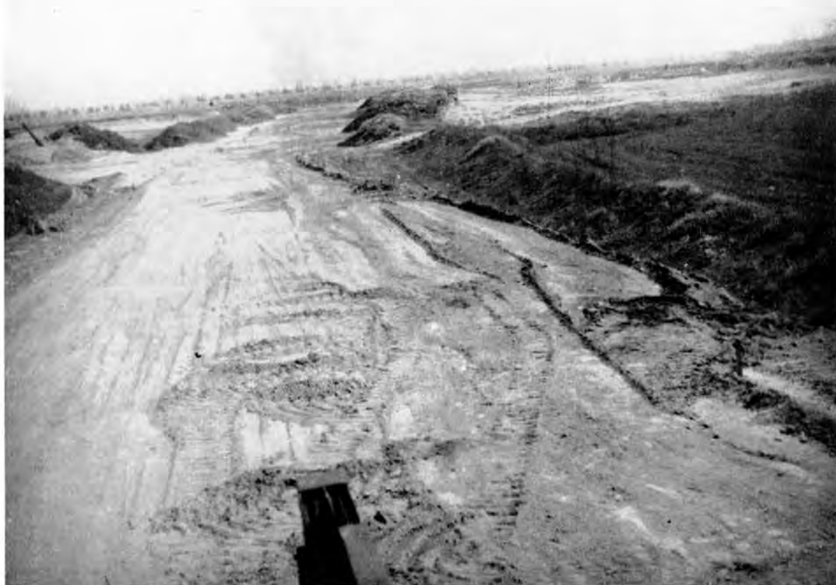
Obr. 3. Sládkovičovo. Pohľad na lokalitu po začatí zemných úprav na stavbe cesty Bratislava–Nitra.
