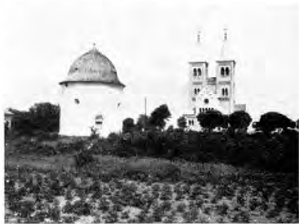
Obr. 13. Bina. Rotunda a románsky kostol; pohľad zo západnej strany.
