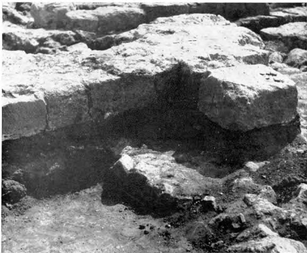
Obr. 5. Levice — Baratka. Zvyšky kvádrového muriva v severnej časti západnej steny kostola II s časťou bočnej steny veže.
