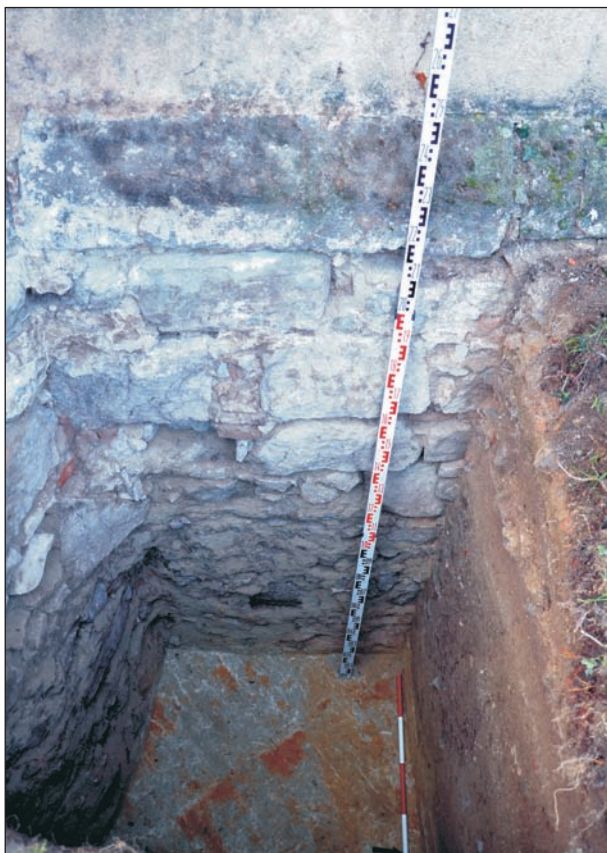
Obr. 18. Hontianska Vrbica. Sonda 4 – základové a nadzákladové murivo dnešného presbytéria a oporného piliera. Pohľad z juhu.
