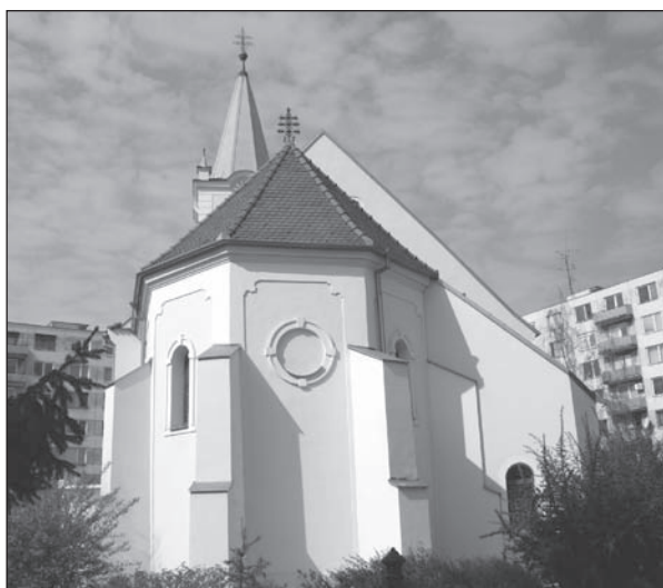
Obr. 1. Dunajská Streda. Kostol Nanebovzatia Panny Márie. Pohľad na gotickú fasádu kostola.
