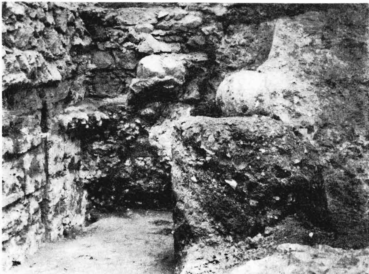
Obr. 4. Bratislavský hrad. Základy brány so zvyškami dreveného šalovania. Foto Kedro.
