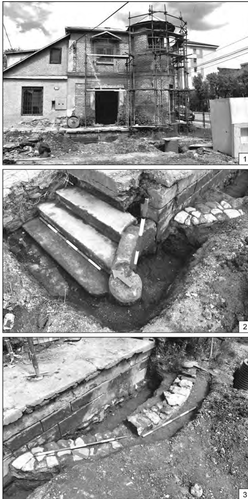
Obr. 23. Hnúšťa (Petřivaldského vila). 1 – vila počas obnovy, v popredí sonda 1/2021; 2 – pôvodný vstup na terasu - schodište zhotovené z liateho betónu so zachovanou balustrádou; 3 – odkrytý pôdorys verandy vily kamennej a tehlovej konštrukcie (foto A. Botoš). (Botoš, 44).
