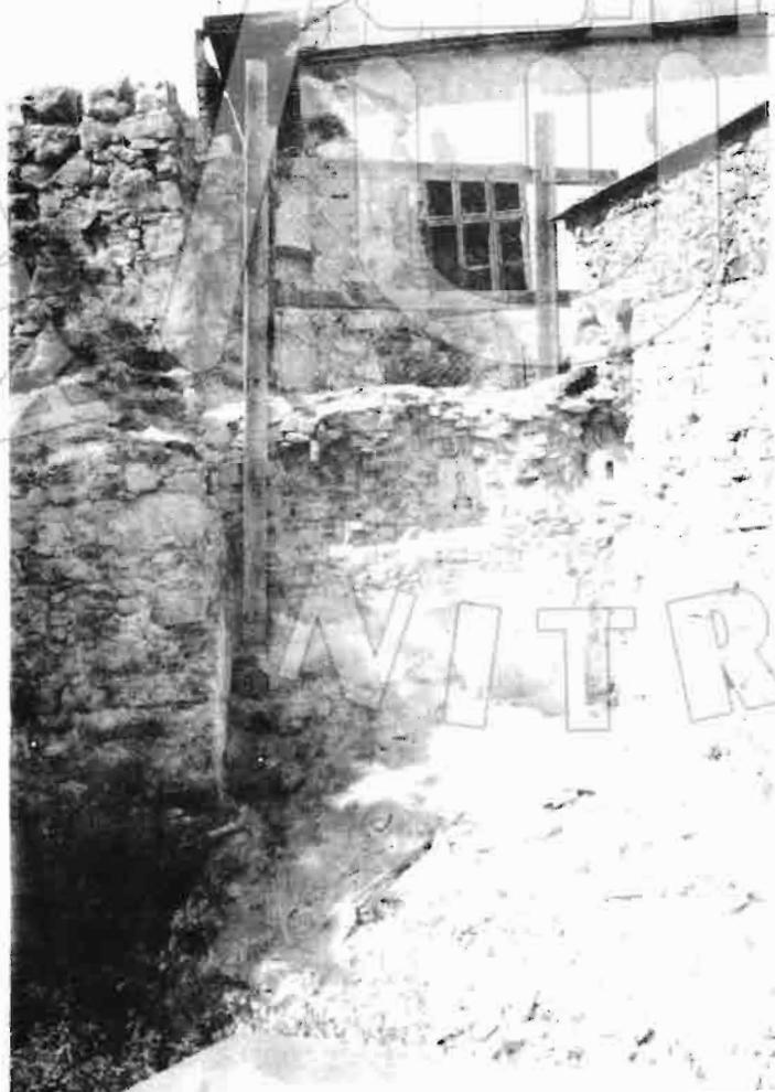
Obr. 95. Banská Štiavnica. 1 - kamenné murovivo hradby, lemujúcej areál Kammerhofu z JZ, s dvoma prístavbami; 2 - úsek hradby v mieste vstupu do dolného nádvoria Kammerhofu. (S. Tóthová, s. 236.)
