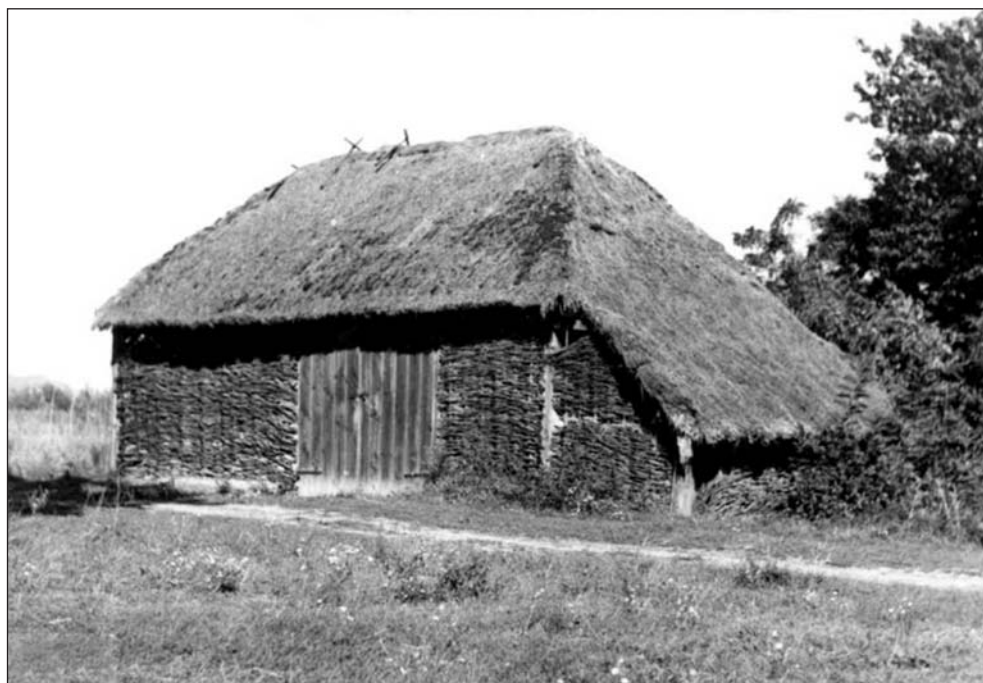
Obr. 6. Čáčov. Stodola kolovej konštrukcie s prúteným výpletom stien. Foto: V. Urbancová 1956 (podľa www.ludovakultura.sk ).
