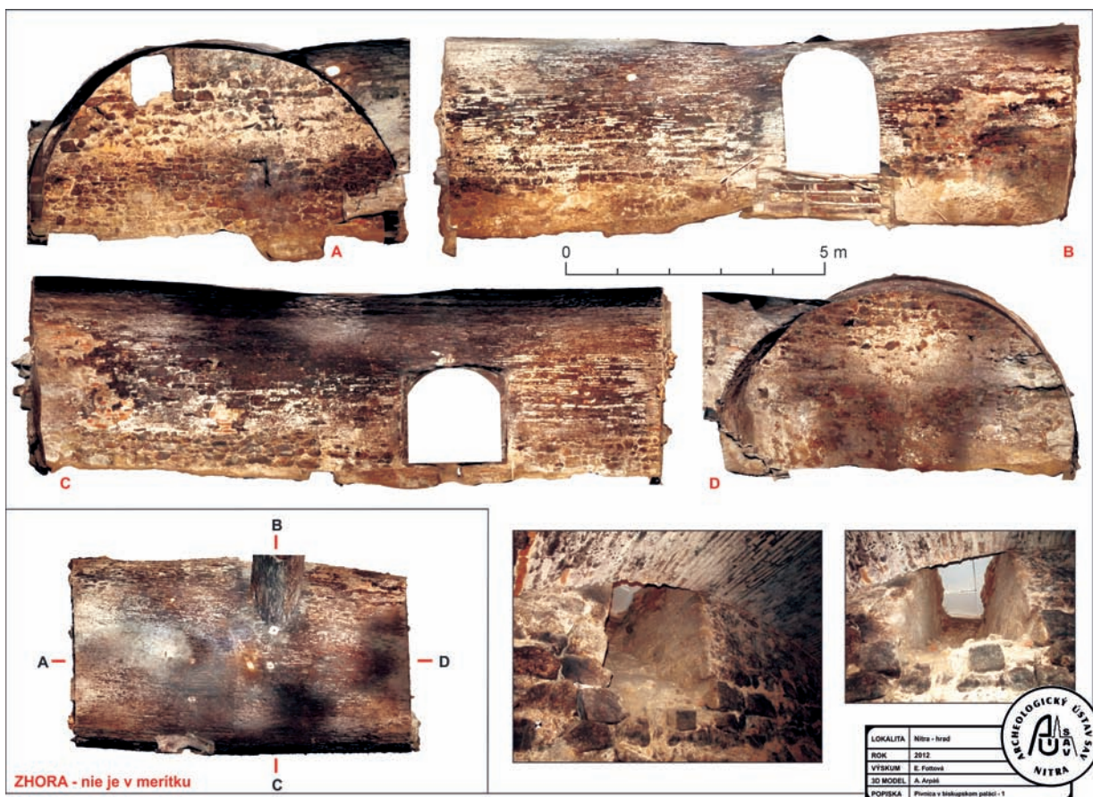
Obr. 19. Nitra-hrad. Fotogrametricky spracované podzemné priestory pod biskupským palácom. AÚ SAV výskum: P. Bednár, E. Fottová; fotogrametria: A. Arpáš, B. Balžan.
