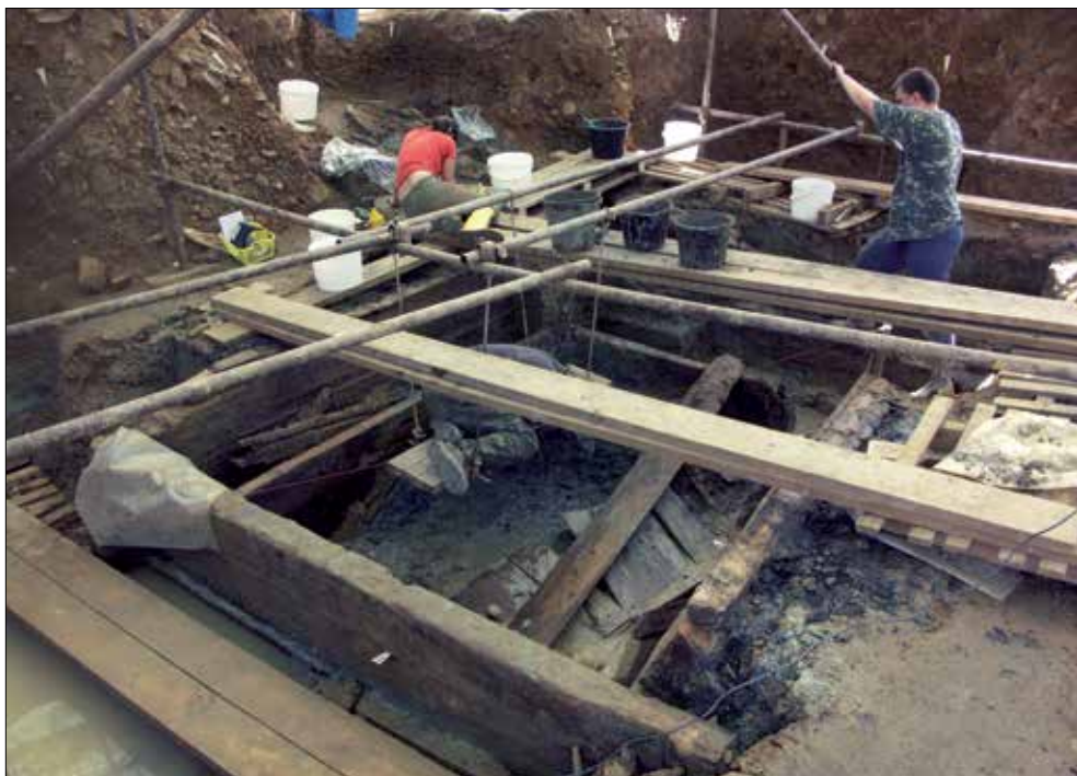
Obr. 19. Objekt bol zabezpečený trubkovou konštrukciou so zavesenými pracovnými plošinami. Foto K. Pieta.
