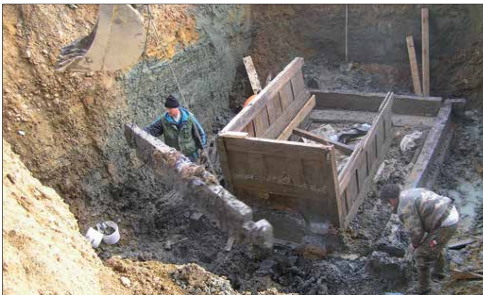
Obr. 34. Rozoberanie drevenej konštrukcie. Foto T. Štolcová.
