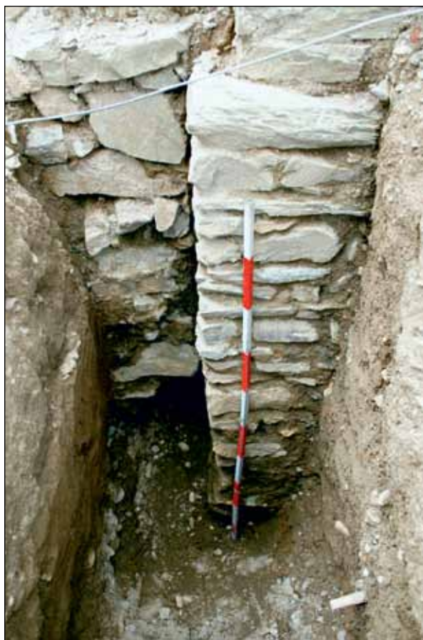
Obr. 30. Košice. Kaplnka sv. Michala. Sonda D. Detail pripojenia základov kaplnky a severnej prístavby (foto M. Bielich).
