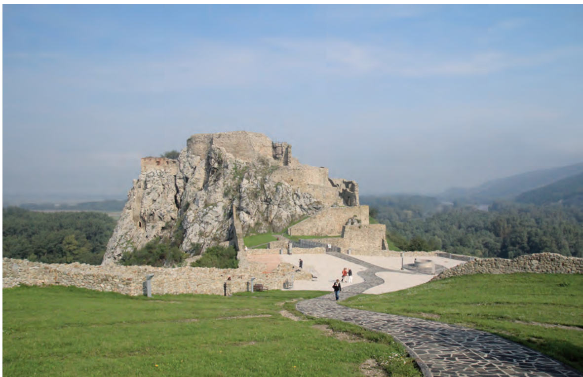
Obr. 2. Devín. Pohľad na horný hrad a nádvorie so studňou. Archív AÚ SAV. Foto: P. Bednár.
